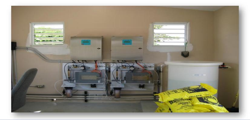
• El sistema MIOX se utiliza para producir el cloro a ser inyectado en el efluente. Este sistema separa a través de placas electrostáticas, una mezcla regular de sal/agua en Sodio (Na) y Cloro (Cl<sub>2</sub>). El cloro resultante de este proceso, es inyectado al agua tratada para su desinfección. El nivel aceptable minimo de presencia de Cl residual debe ser de 1.0
